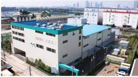
東京中間処理工場
